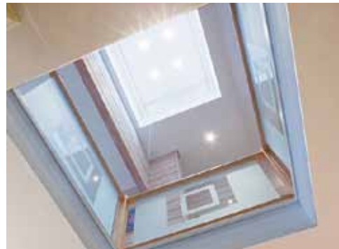
← Aulaan virtaa runsaasti päivänvaloa idästä ja lännestä, mutta myös tornimaisen kattoikkunan kautta.
